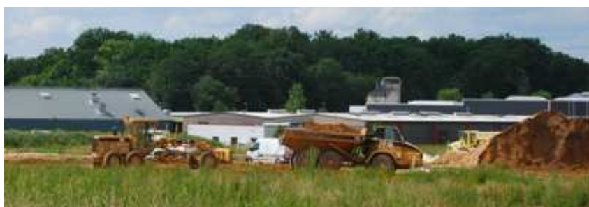
Photographie 1: Préparation du terrain pour la construction d'une zone d'activité (RB Fontainebleau-Gâtinais)
