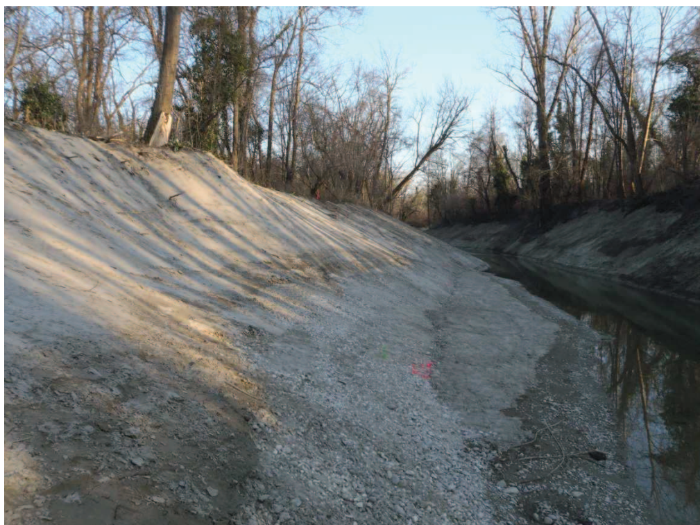
Figure 132: Alluvions à proximité d'un bras restauré de la lône de la Platière – On note la présence d'une couche limoneuse qui recouvre une couche plus riche en graviers.
