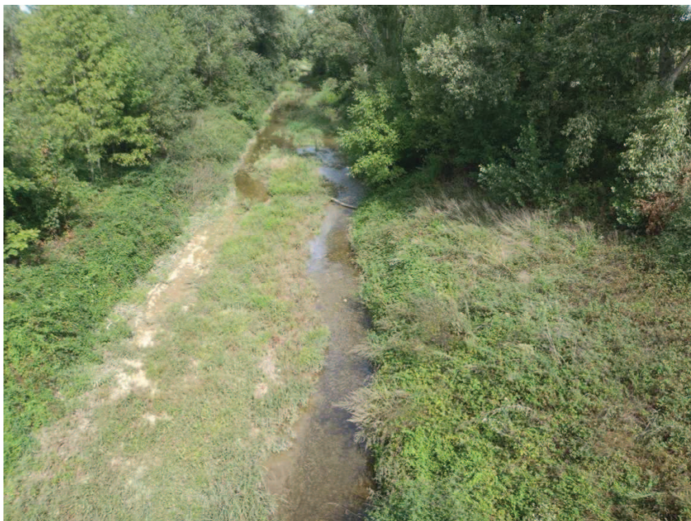
Figure 130: Débouché de la Sanne en période estivale - On note le faible débit et l'infiltration de l'eau dans la nappe.
