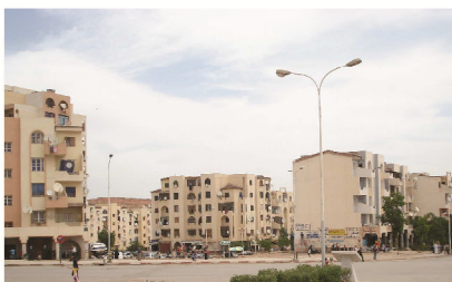
Au niveau de l'UV7, l'interstice entre les deux immeubles au premier plan est réapproprié par les habitants. Cette sorte d'espace public improvisé est un témoin de l'occupation humaine de la zone. Tous les jours, s'y retrouvent des personnes âgées pour discuter, de même que des groupes de jeunes, écoliers lyéens et autres. C'est aussi un lieu qui fait office d'une des principales stations de taxis.
