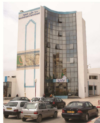
Sur une façade de bâtiment universitaire
