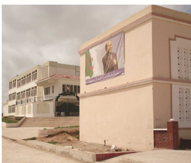
Sur une façade d'école
