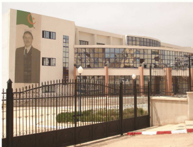
Sur une façade de bâtiment universitaire
