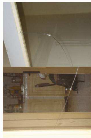
Vitrages fendus par « de simples courants d'air »
