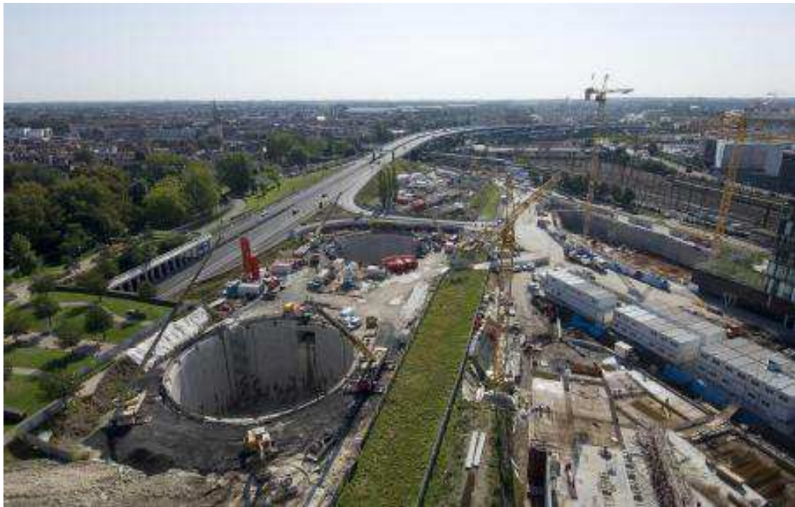
Figure 1: bassins de stockage des eaux pluviales en construction à Lille – Fives, image Lille Métropole
