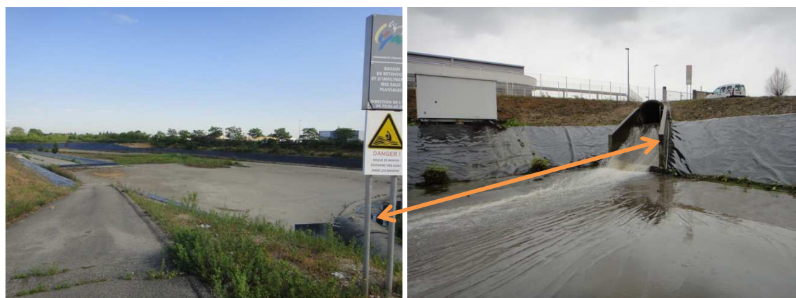
Figure 18 : bassin de rétention des eaux de Chassieu, par temps sec (à gauche) et par temps de pluie (à droite), photographies personnelles
