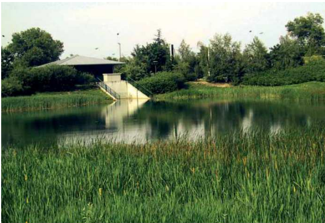
Figure 2 : bassin de stockage (en permanence en eau) des eaux pluviales à Saint Priest (Porte des Alpes), image Grand Lyon
