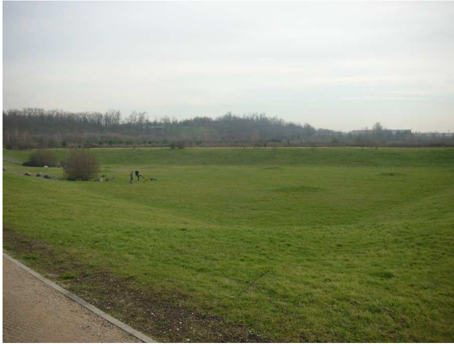
Figure 3: bassin de stockage (sec) des eaux pluviales à Saint Priest (Minerve), photographie personnelle
