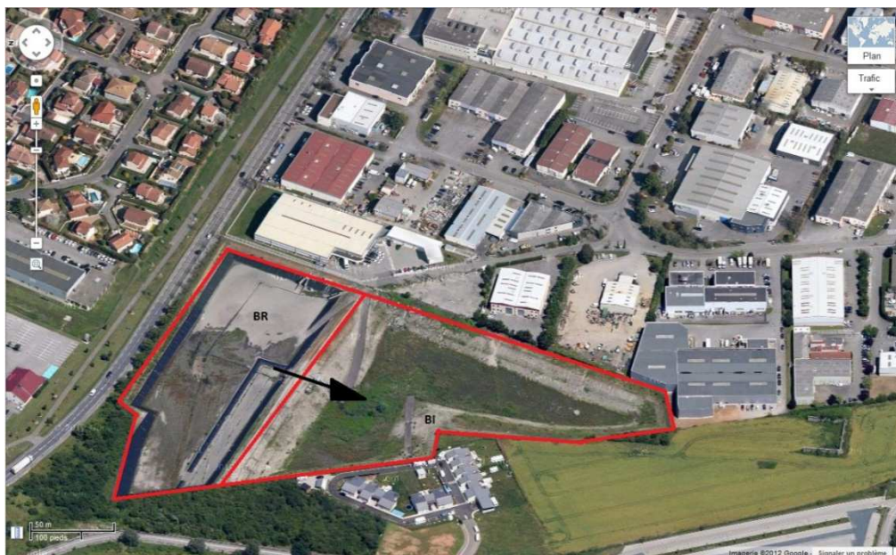
Figure 17 : bassin de rétention (BR) (à gauche) et d'infiltration (BI) (à droite) des eaux de Chassieu, source : google maps
