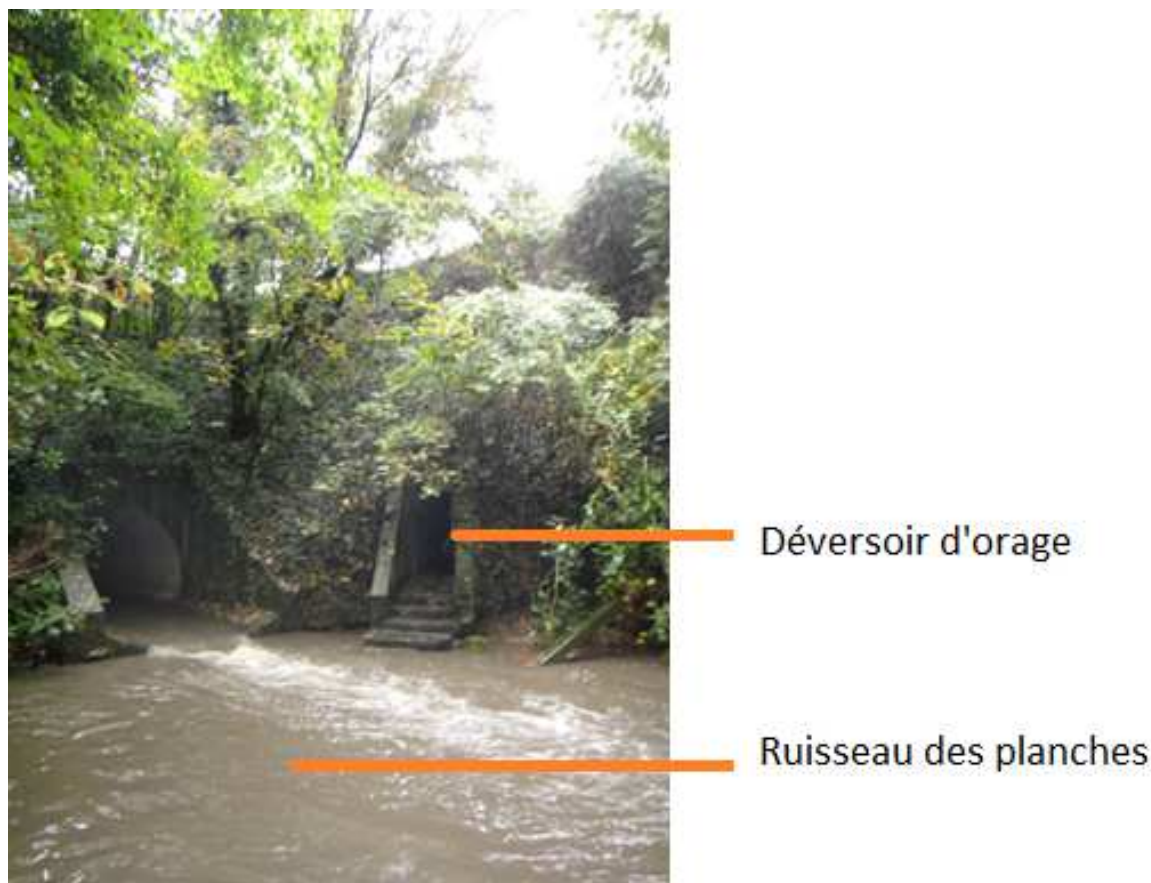
Figure 16 : ruisseau des planches et déversoirs d'orage à Ecully, photographie personnelle
