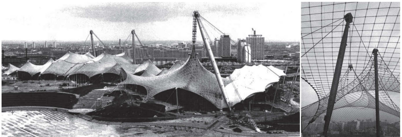
Figure 108. Toiture du stade olympique de Munich constituée d'un réseau de câbles
