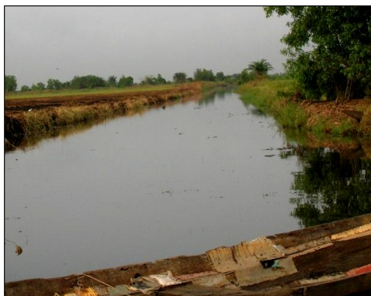
Photo 3 : Le canal de Gbéssou reliant le village et Nokoué, 2 km de long, 3 m environ de large et 2 m de profondeur en étiage (Sossou-Agbo, 2009)
