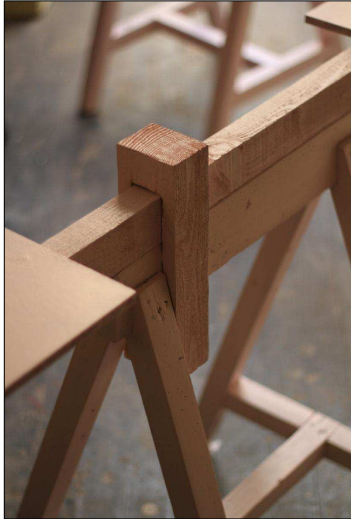
Vue partielle d'assemblages, atelier, juillet 2012.
