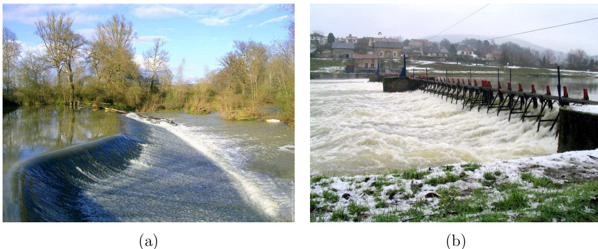
FIGURE 1.1 – (a) Seuil de régulation passif, rivière Arros (France, Hautes-Pyrénées). Photographie : "Camélia", 2007 (b) Seuil à niveau variable sur la Meuse (France) Source : Wikipedia, Photographie : "Karel Roose", 2004
