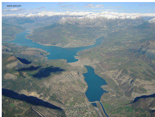
FIGURE 2.2 – Barrage de Serre-Ponçon. La retenue est alimentée par la Durance et l’Ubaye. La réserve de Espinasses peut être observée dans le bas de la photo. Cette retenue est le point de départ du canal usinier EDF sur la branche Durance. Photo : ‘Camille Sim’
