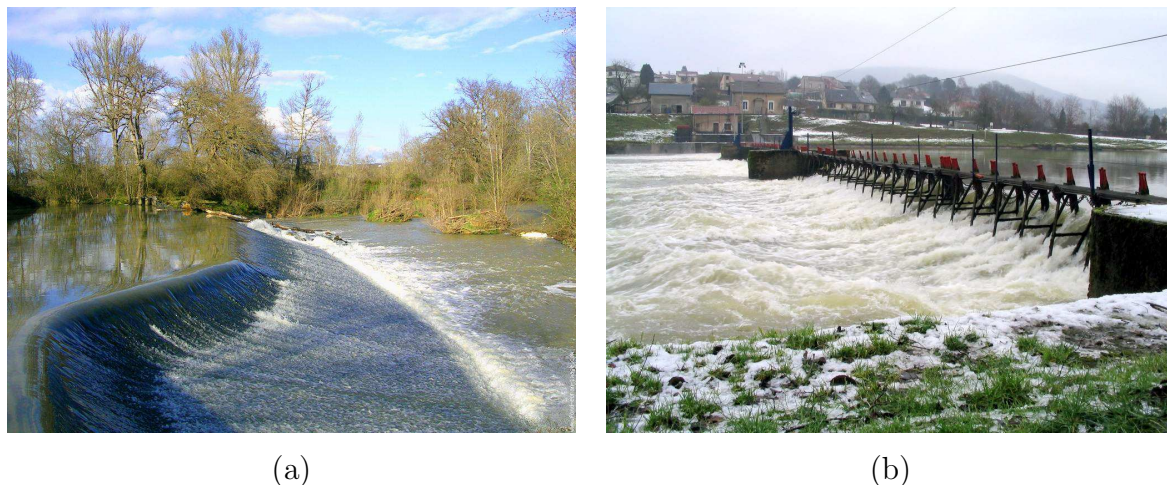
FIGURE 1.1 – (a) Seuil de régulation passif, rivière Arros (France, Hautes-Pyrénées). Photographie : "Camélia", 2007 (b) Seuil à niveau variable sur la Meuse (France) Source : Wikipedia, Photographie : "Karel Roose", 2004
