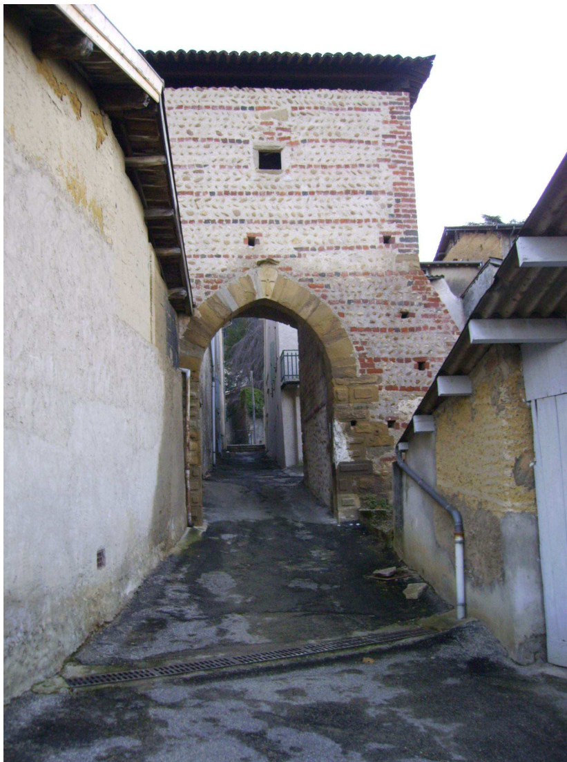
Doc. 64. Porte inférieure de Moras vue depuis l'extérieur du bourg médiéval
