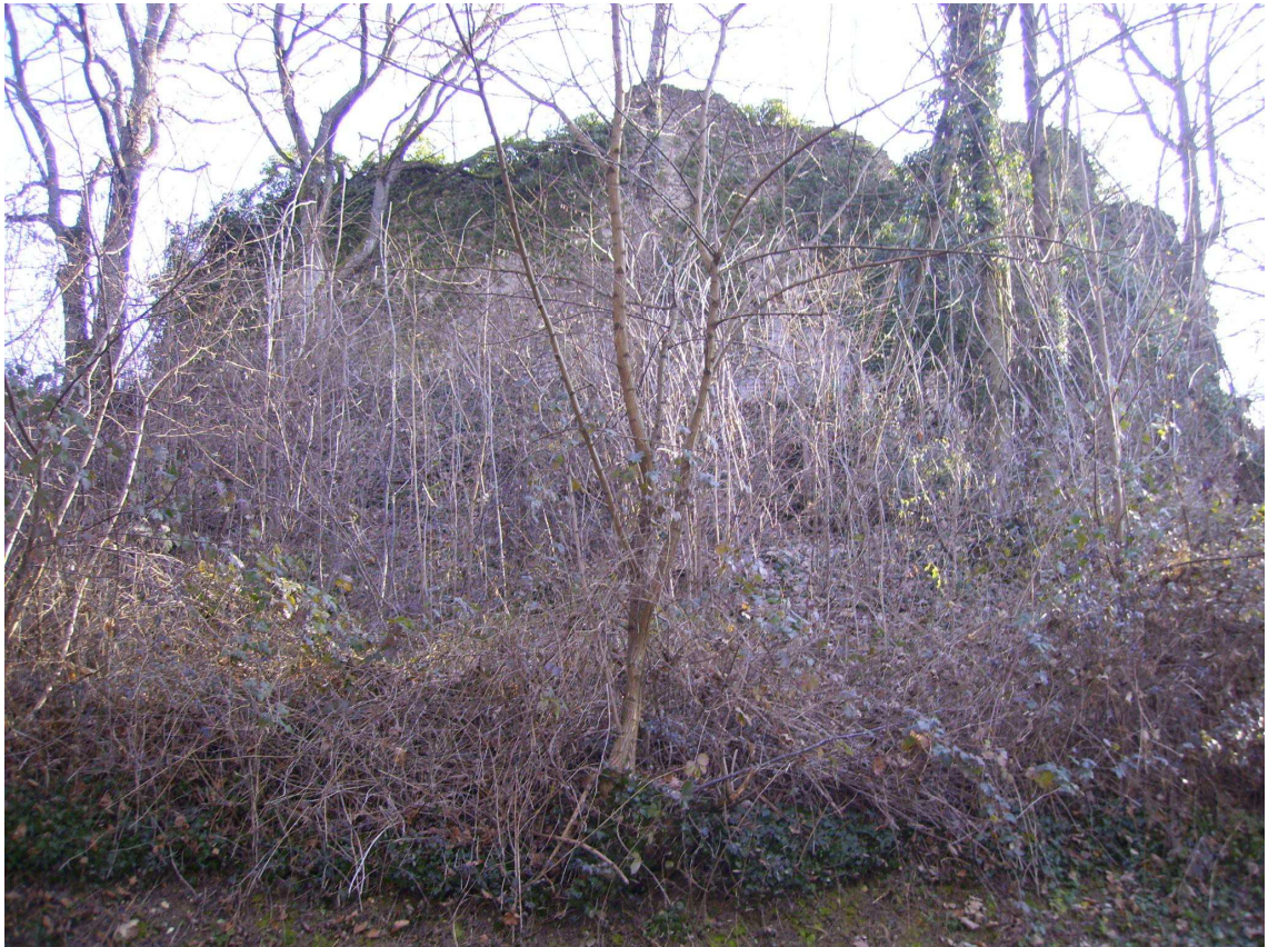
Doc. 30. Tour carrée des braies du château de Montluel
