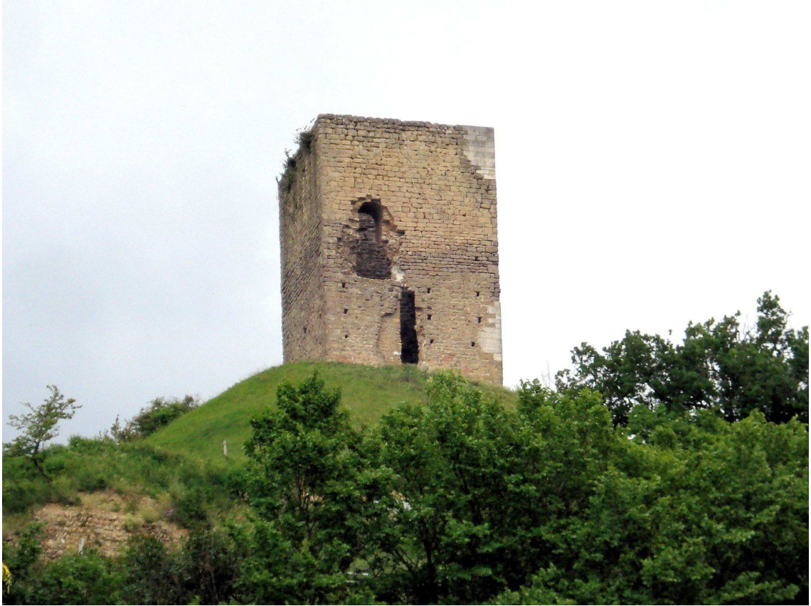
Doc. 168. Façade nord-ouest de la tour d'Albon 907
