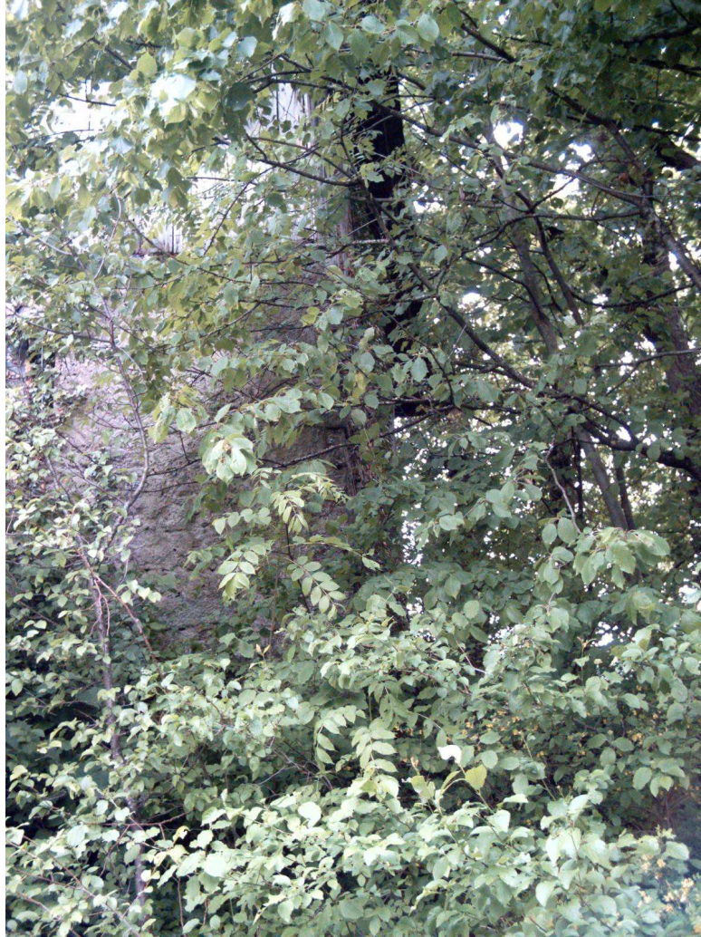
Doc. 103. Vestiges de la tour de l'enceinte du château de Sallanches
