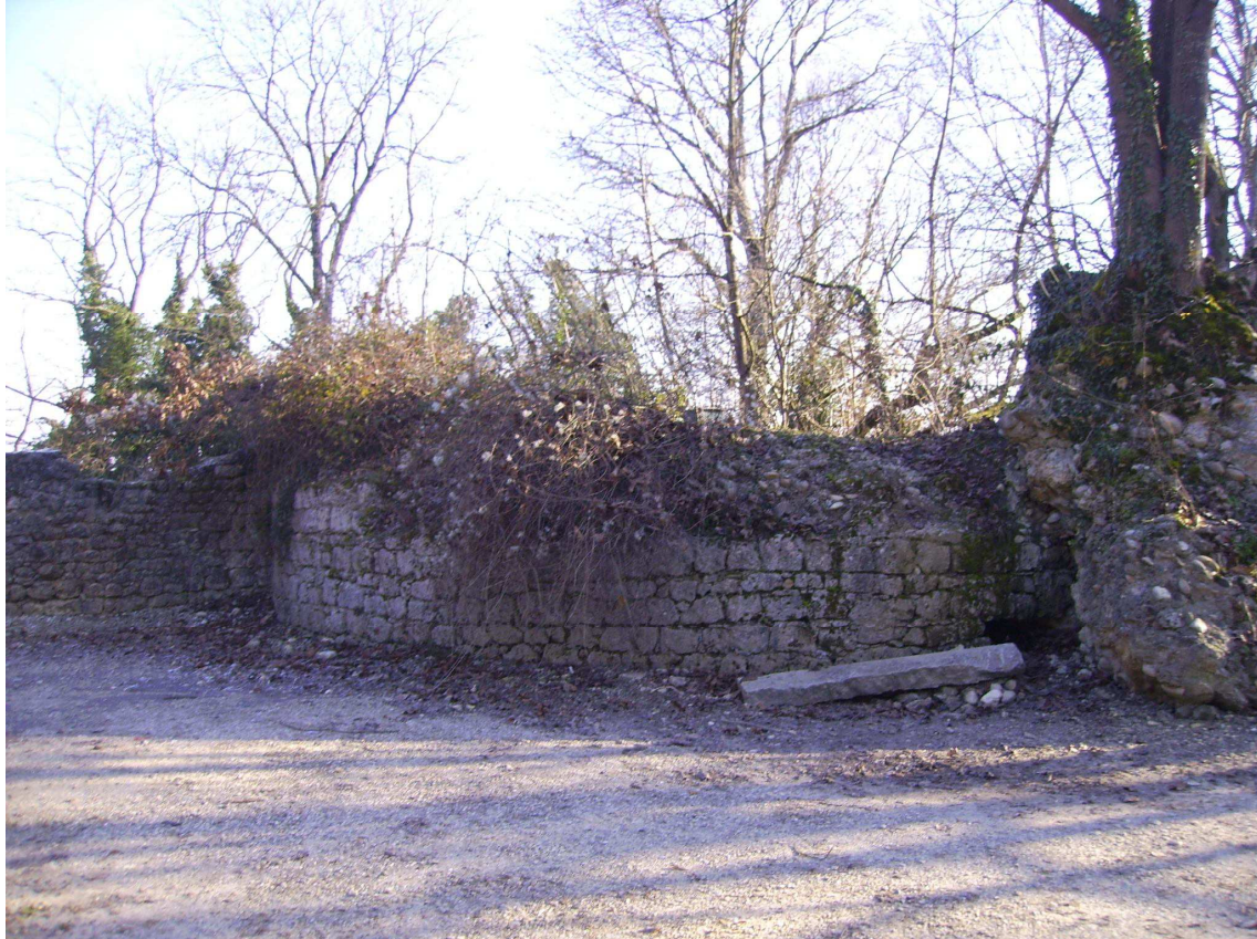
Doc. 34. Base de la tour ronde du vieux château de Montluel
