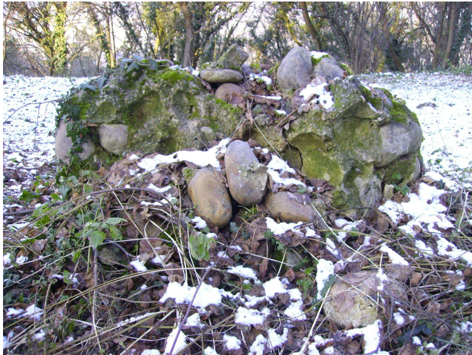
Doc. 73. Pan de mur en élévation au pied de la tour carrée
