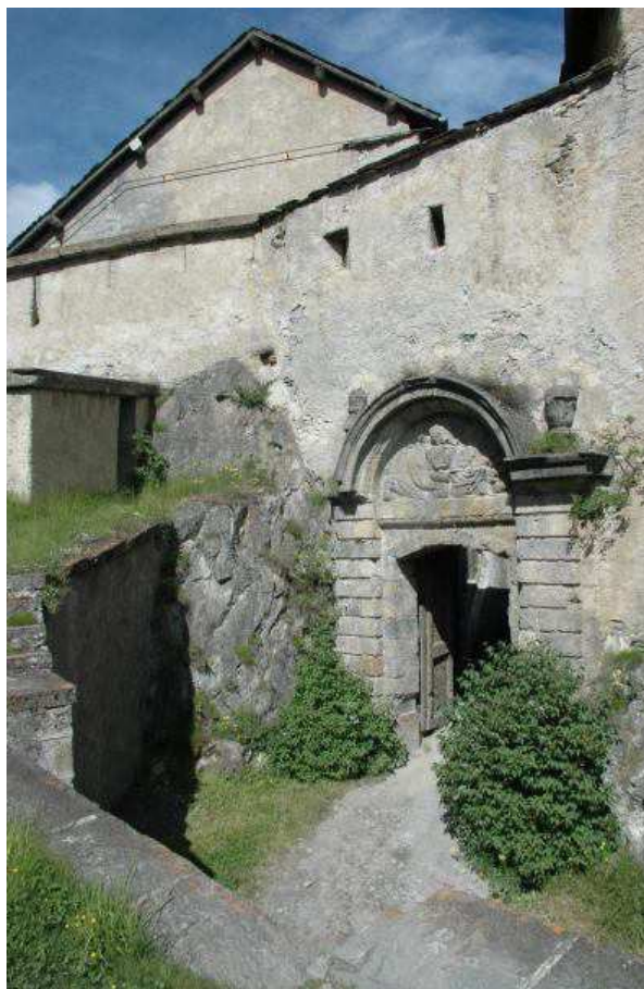
Doc. 142. Porte de la basse-cour de Château-Queyras 785
