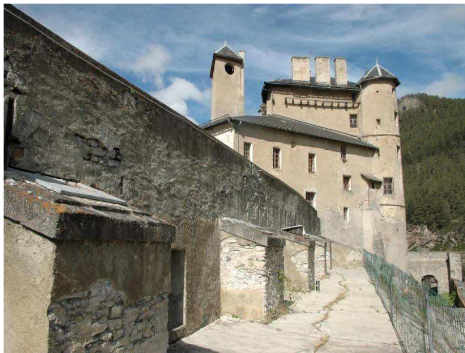
Doc. 141. Mur nord de la basse-cour de Château-Queyras
