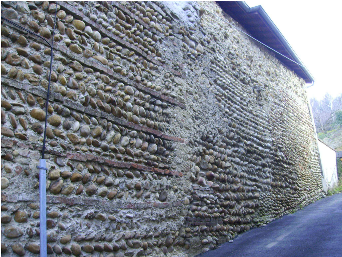
Doc. 63. Rempart oriental de Moras vu de l'intérieur du bourg
