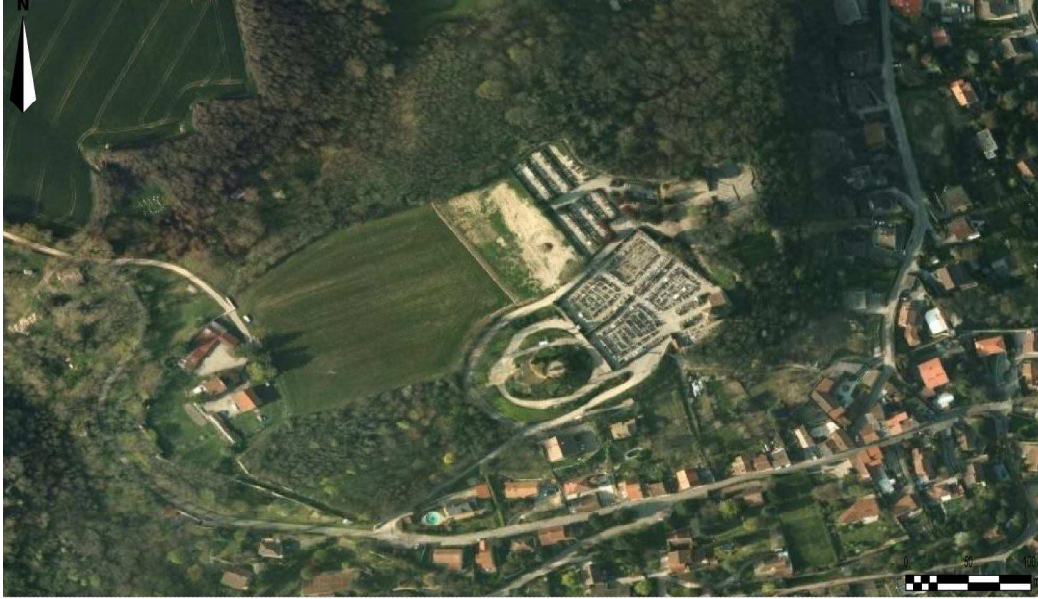
Doc. 28. Vue aérienne du site castral de Montluel (2007) © Telatlas
