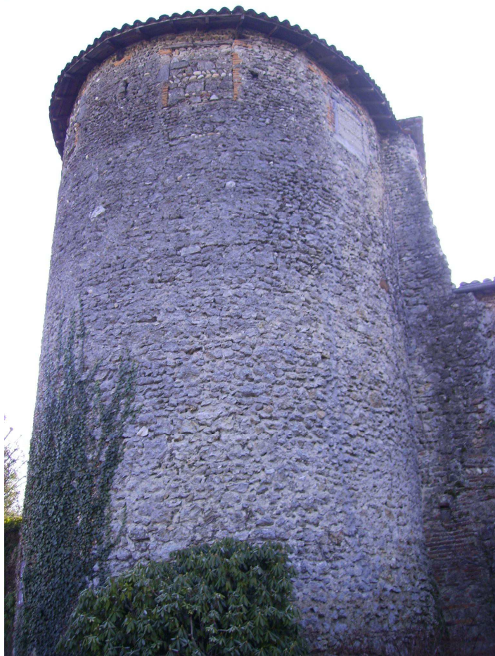
Doc. 39. La tour Mandot vue de l'extérieur du bourg de Montluel
