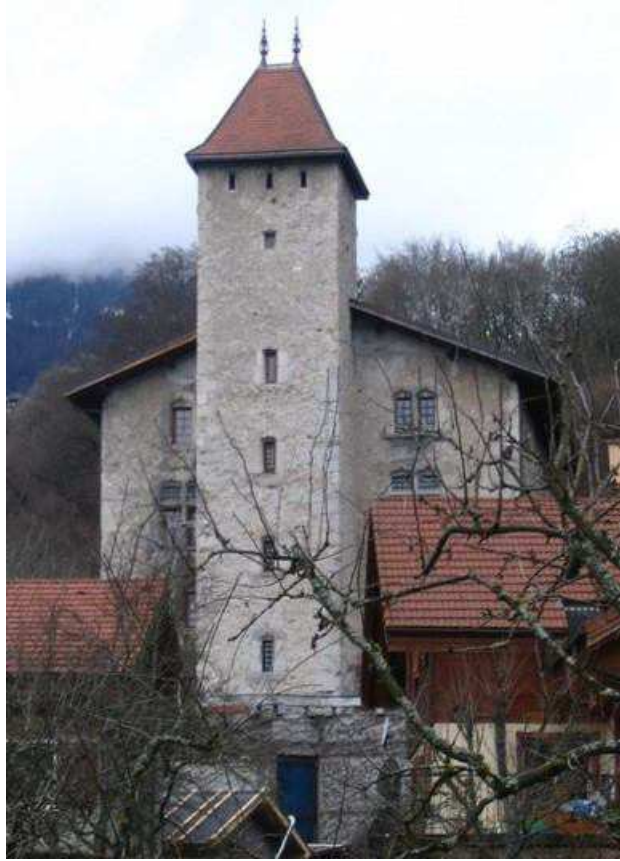
Doc. 111. Façade orientale du château des Rubin 690
