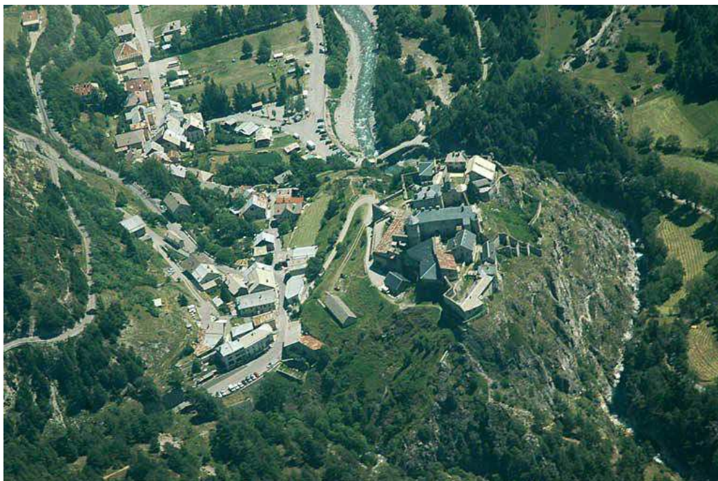
Doc. 138. Vue aérienne du site de Château-Queyras © Monuments Historiques 775
