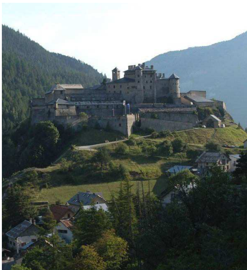
Doc. 139. Vue du site de Château-Queyras depuis le nord-est 776
