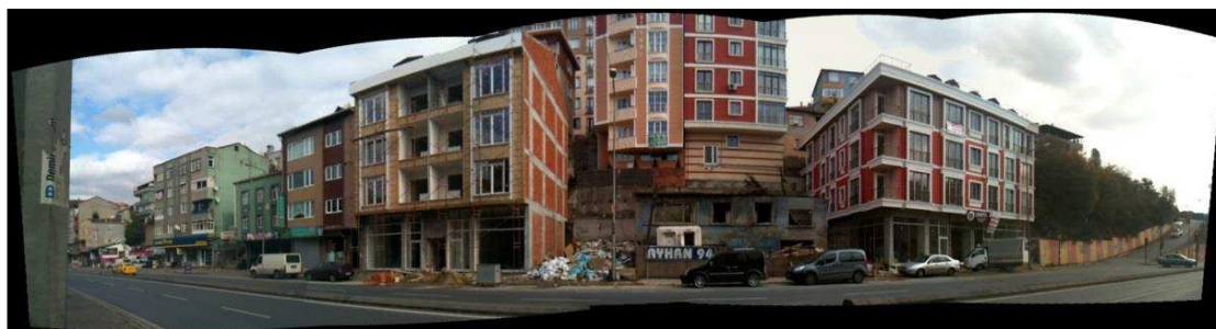
Photo 21: Construction face de Santralistanbul (source : photo personnelle)
