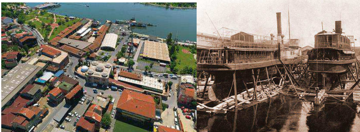
Photo 24: le chantier naval de Hasköy (source : www.rmk-museum.org.tr )
