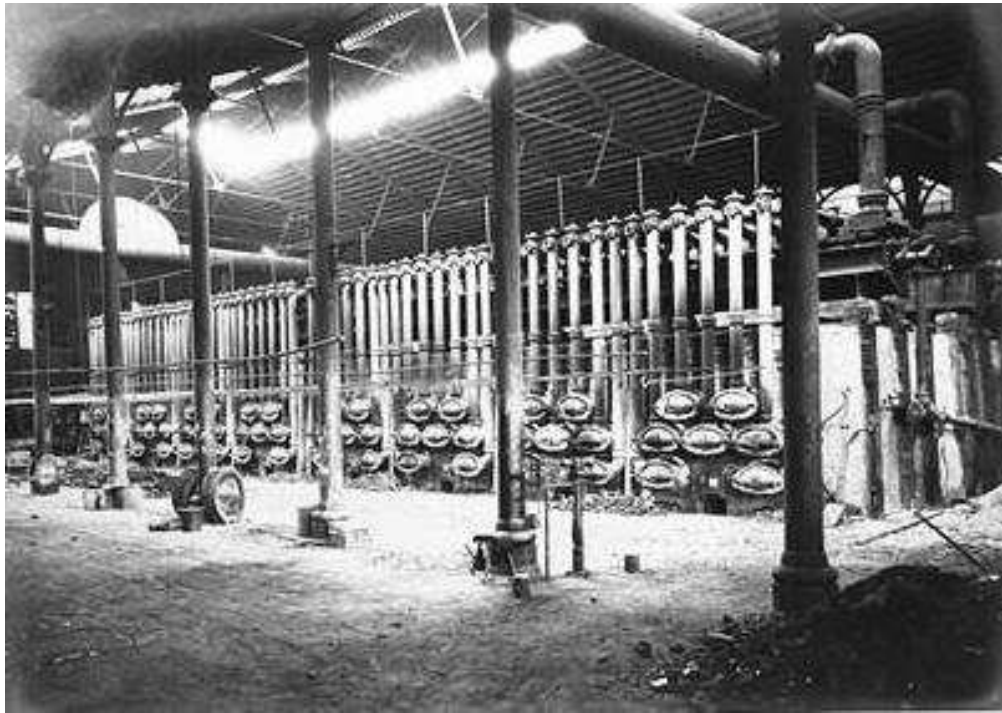
Figure 4.2. Atelier de distillation de l'usine à gaz de la Villette de la Compagnie Parisienne d'Eclairage et de Chauffage par le Gaz (CPECG) au milieu du XIXe siècle. Source : gauche - Fernique, 1878-1880, droite - Figuer, 1870, p. 136.
