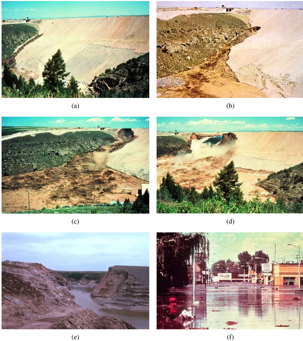
FIGURE 1: Rupture du barrage de Teton (107m de haut) aux Etats-Unis en 1976 : (a) construction du barrage de Teton terminée ; (b) un conduit traversant a été formé et l'eau du réservoir s'écoule petit à petit ; (c) le conduit continue à s'agrandir et remonte vers la crête ; (d) formation d'une brèche ; (e) rupture et vidange du réservoir ; et, (f) front d'inondation à travers Rexburg, Idaho [136, 159].
