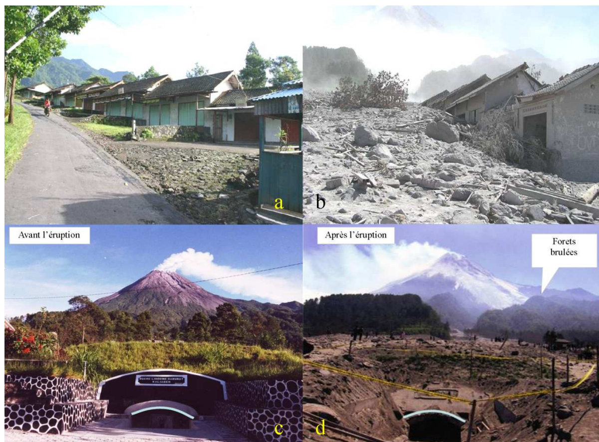
Figure 66. Le site de Kaliadem et son bunker (a, c) avant 2006 et (b, d) après leur destruction par des PDCs (Source : Kabupaten Sleman, 2009).
