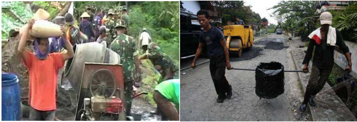
Figure 52. Travaux collectifs pour bitumer les routes d'évacuation (Detik Foto, 2010)
