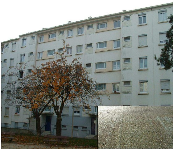
(a) Toit terrasse en bitume
