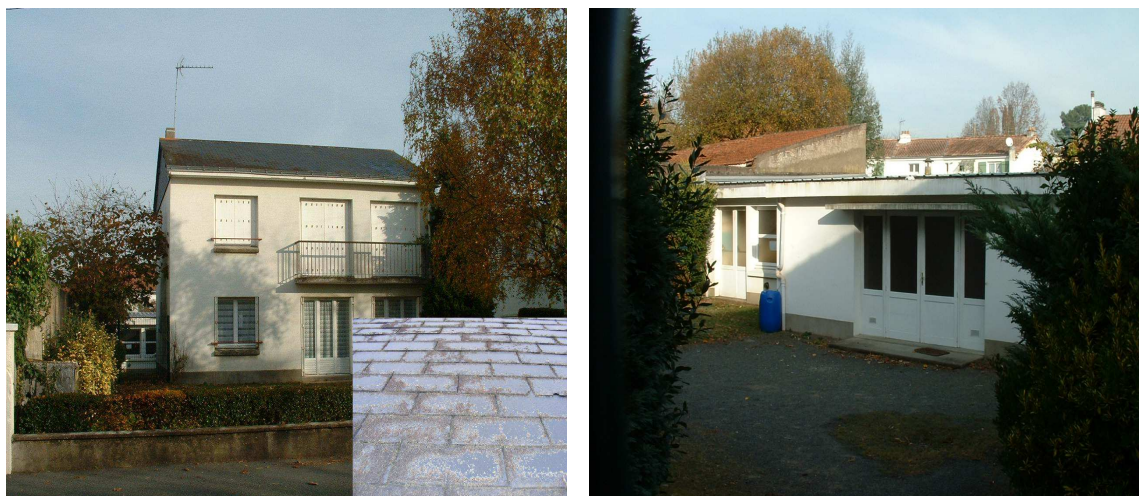
(a) Toit en ardoise
