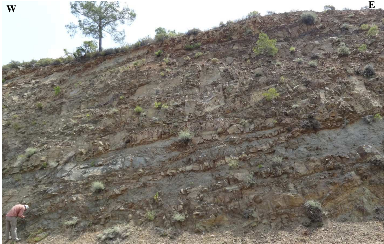
Figure 2.19 : Photographie illustrant des dykes non épidotisés recoupant un dyke entièrement épidotisé. Affleurement localisé sur la route d'Oikos-Gerakies.
