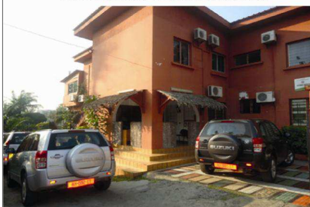
Siège de l'ANPN à Libreville (A. Mouloungui, 2012). L'Agence dispose d'un bâtiment annexe dans un quartier résidentiel de la capitale, où siège le Secrétaire Général
