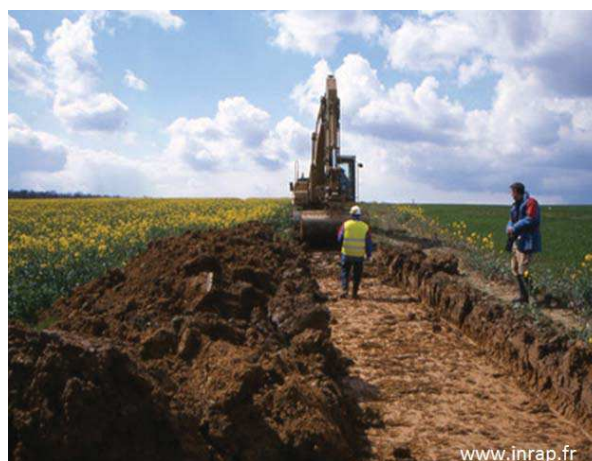
Fig. 20. Décapage de la couche organique.
