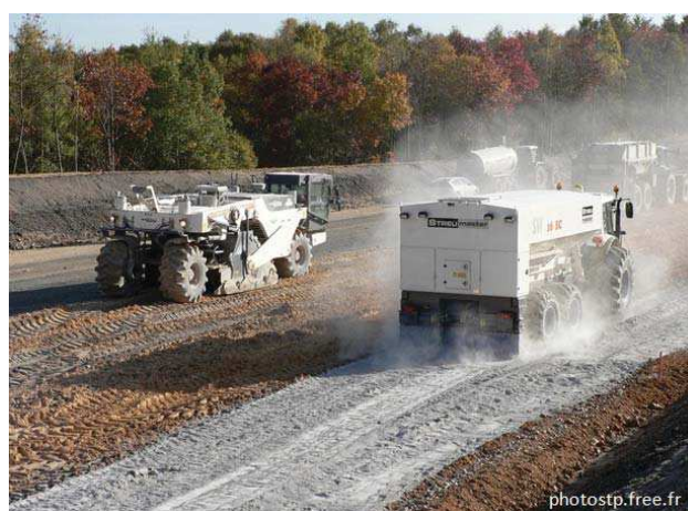
Fig. 23. Traitements aux liants hydrauliques.
