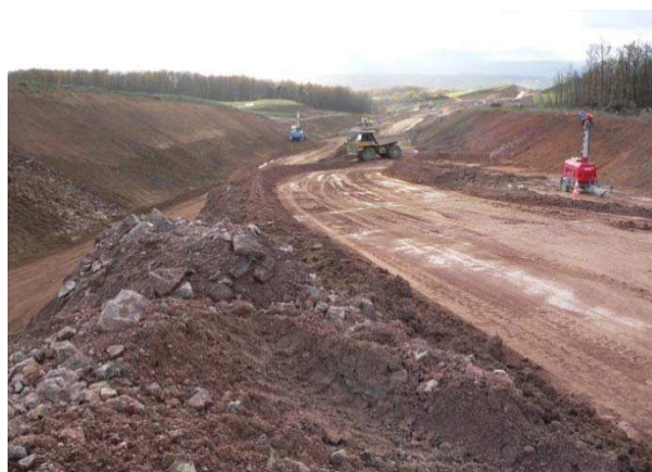
Fig. 22. Zone Déblais/Remblais de la A89.
