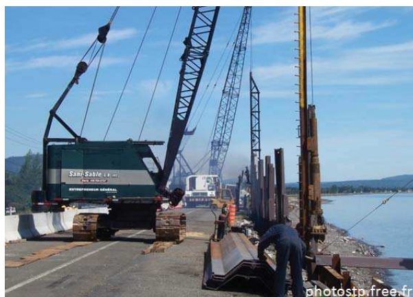
Fig. 21. Rideau de palplanches pour travailler hors eau.
