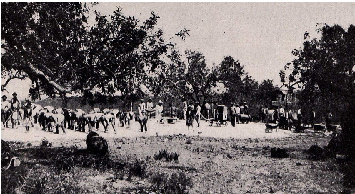
Figura 11: Recurso ao trabalho intensivo de trabalhadores rurais para as obras em estradas nacionais 100
