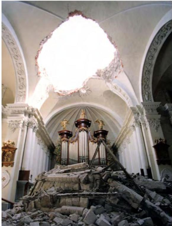
**FIGURE 9-13** : Toit de la cathédrale d'Arequipa percé par l'effondrement de l'une des tours lors du tremblement de terre de 2001. Photo : Fredy Salcedo, 2001.
