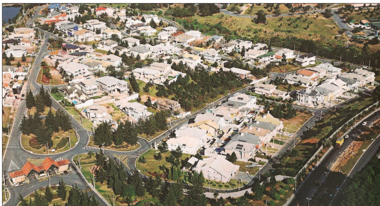
Fig. 24 : Vue aérienne du Residencial 18 do Forte, Alphaville, 2003
