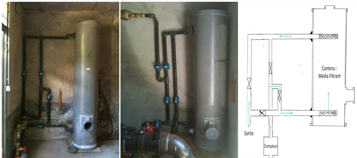
Figure 4.5 : Unité pilote de traitement de l'arsenic par filtration sur zéolithe enrobée d'oxyde de fer à St Sauveur sur Tinée (A) et à Berthemont les bains (B). (C) Schéma de fonctionnement.
