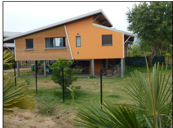
Photographie 61 : Les habitations sur pilotis construites en zone inondable à 200m de l'Étang Saint Paul (Réunion)
