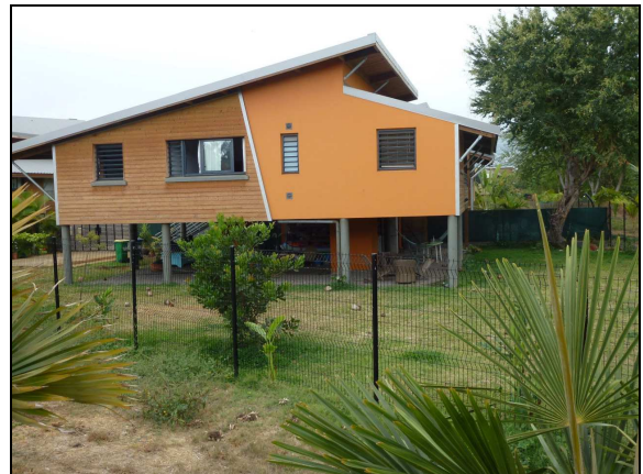
Photographie 61 : Les habitations sur pilotis construites en zone inondable à 200m de l'Étang Saint Paul (Réunion)
