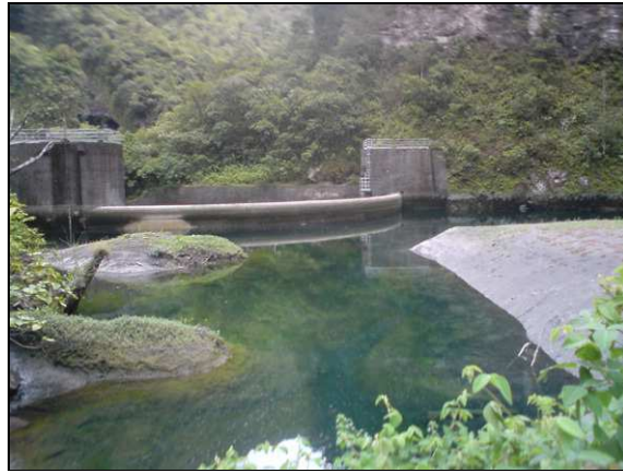
Photographie 15 : Le lac de barrage de Takamaka 2 en partie comblé
