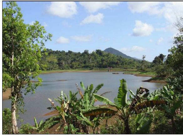
Photographie 54 : Le réservoir de Combani (Mayotte), période de basses eaux
