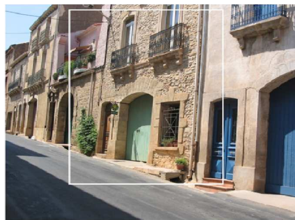
En face, un logement transformé en gîte rural à l'étage, et remise à matériel en rez-de-chaussée
