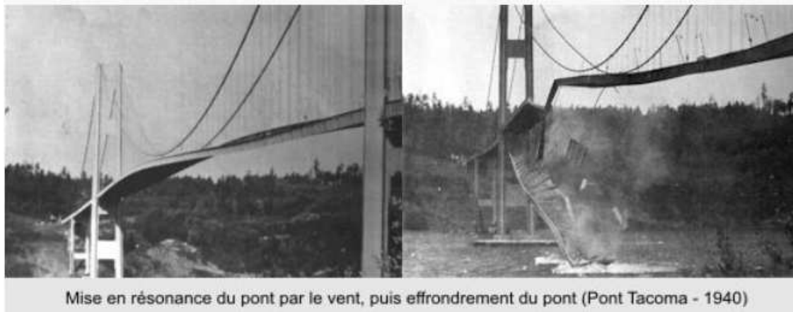
FIGURE 1.6 – Effondrement du pont de TACOMA (U.S.A.) le 7 novembre 1940 causé par un phénomène de résonance dû aux oscillations en torsion provoquées par le vent.
