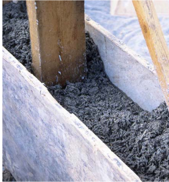
Figure 1-10 : Banchage du béton de chanvre (Bevan & Woolley, 2008)
