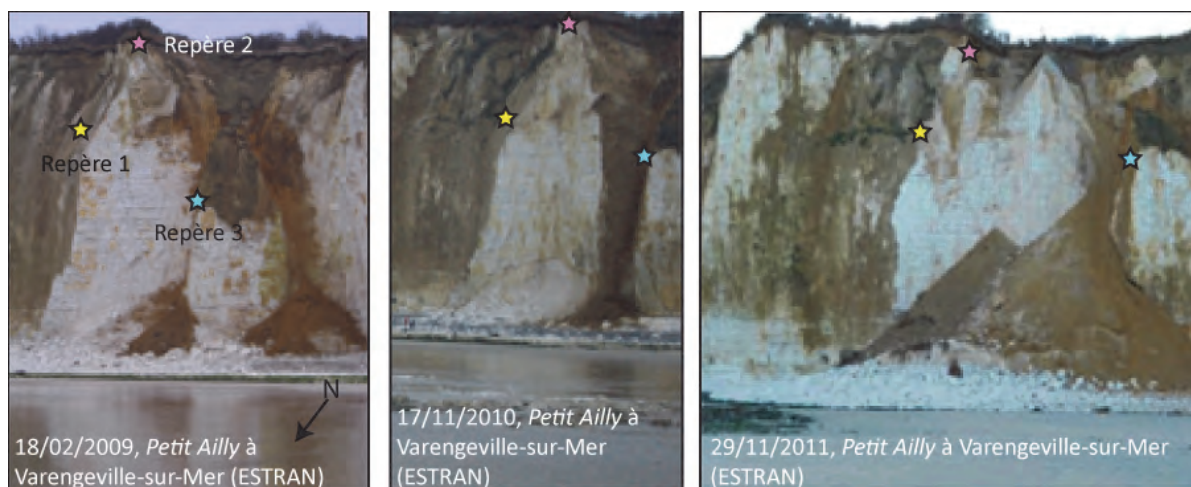
Figure 7.10 : Évolution rapide de la falaise au Petit Ailly (Varengville-sur-Mer) : trois éboulements/écroulements de pan entier de falaise au même endroit
