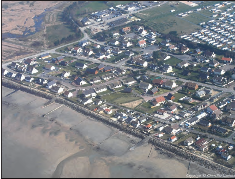
Figure 1.5 : La côte basse sableuse urbanisée d'Asnelles avec ses enrochements et épis
