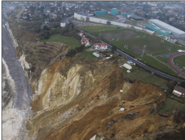
Figure 8.17 : Exemple d'éboulement majeur puis glissement des terrains tertiaires sur la Côte aux Hérons (ouest de Dieppe) (18/12/2012)
