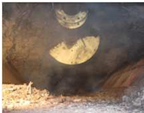
Figure 4.10 – La voûte sous la poutre
