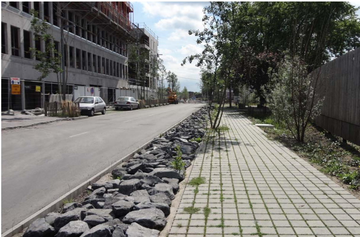
Figure 47 : Écoquartier de la Haute Deûle, Lille, Cheminements hydrauliques plantés et pavage perméable (Photo : Leger-Smith, visite de site 01/06/2012)
