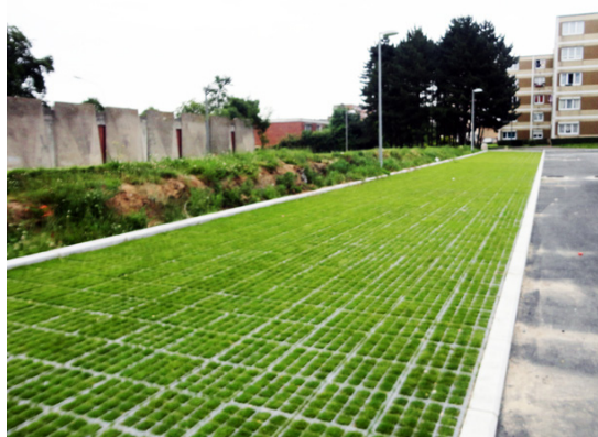
Figure 50 : Écoquartier de Mons-en-Baroeul, revêtements perméables (Photo : Leger-Smith, visite de site 28/06/2012)
