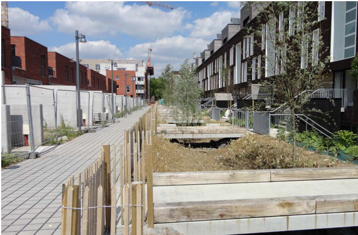
Figure 46 : Écoquartier de la Haute Deûle, Lille, Cheminements hydrauliques plantés (Photo : Leger-Smith, visite de site 01/06/2012)
