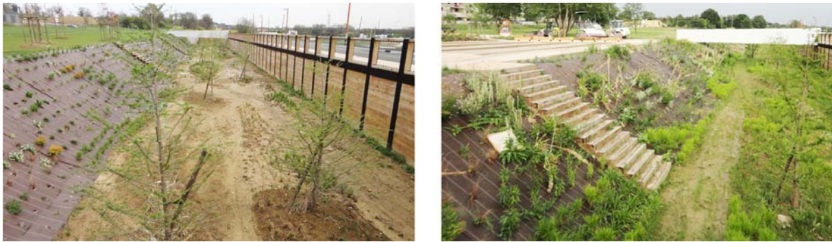
Figure 63: Bassin versant du parc public de Vidailhan aménagé en jardin creux (Photo Leger-Smith, visite de site 10/04/2012 et 19/06/2012).
