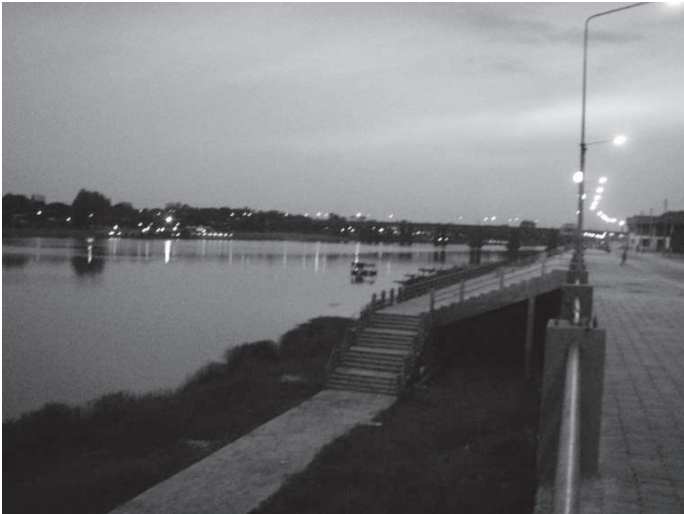
Les quais de la rivière Mun
