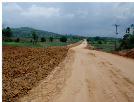
Travaux d'élargissement de la route entre Chiang Khong et Mae Sai (2011)
