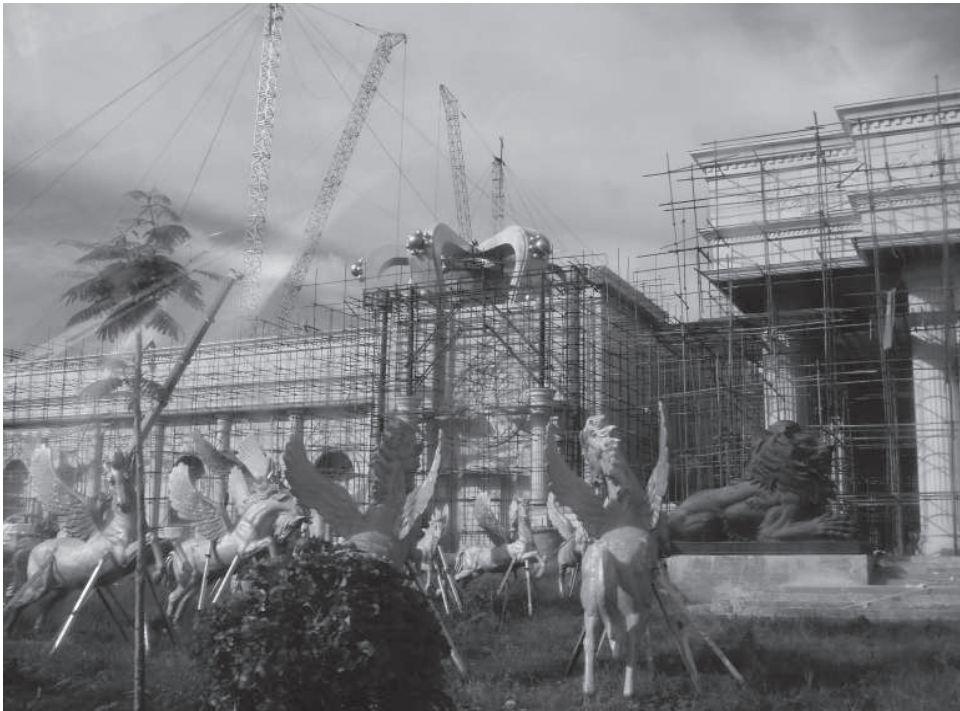
Construction du casino
