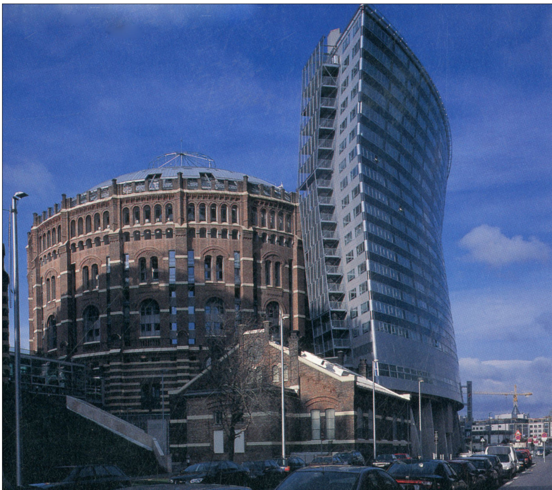
Figure 3.1 Gazomètre B, Vienne, Autriche. Coophimmel(b)lau, 2001. Les architectes ont ajouté une structure verticale au cylindre patrimonial, ancien réservoir à gaz, pour y accueillir des logements et des bureaux. (Tiré de GA document , 2002, p. 72.)
