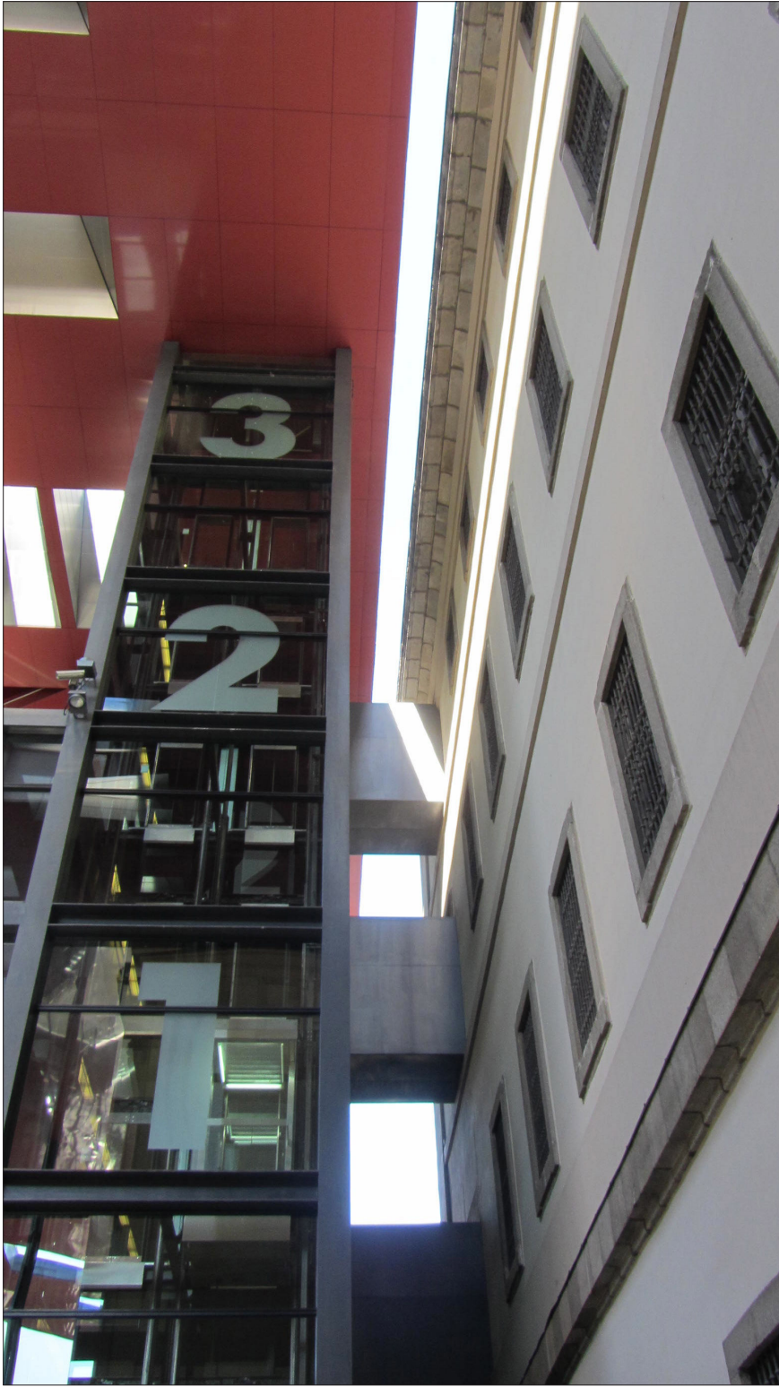
Figure 3.15 Ascenseurs de l'édifice Nouvel. (Alexandra G. Paquin, 2012.)
