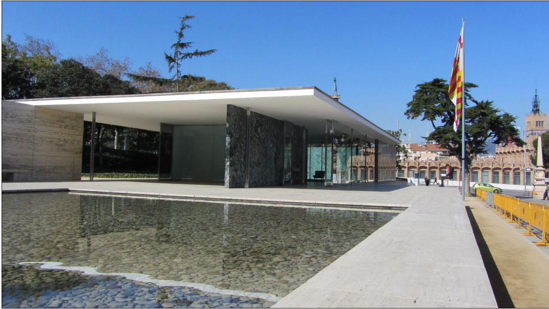
Figure 2.14 Pavillon allemand de Mies van der Rohe, 1929, reconstruit en 1985. Barcelone, Espagne. (Alexandra G. Paquin, 2012.)
