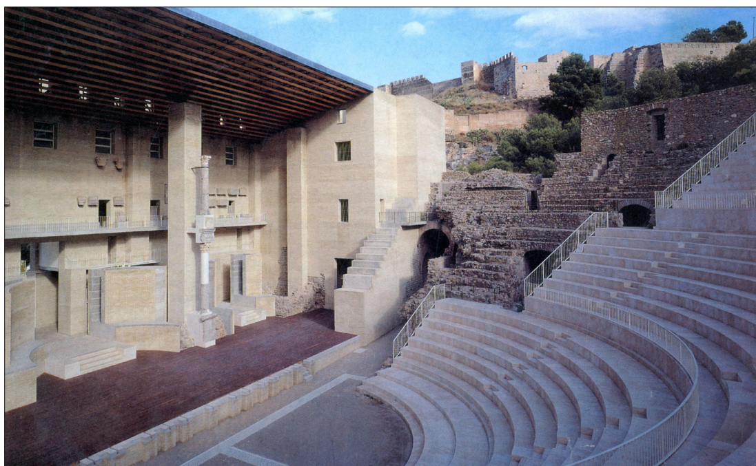
Figure 4.10 Transformation du Théâtre de Sagonte, Espagne. Giorgio Grassi et Manuel Portaceli, 1993. (Tiré de A & V , 1994, p. 100.)
