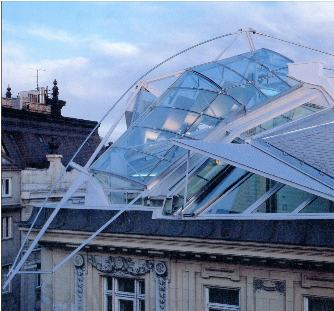
Figure 0.8 Rooftop Remodeling , Falkestrasse 6, Vienne, Autriche. Coop Himmel(b)lau, 1988. (Tiré de A+U , 1989, p. 30.)
