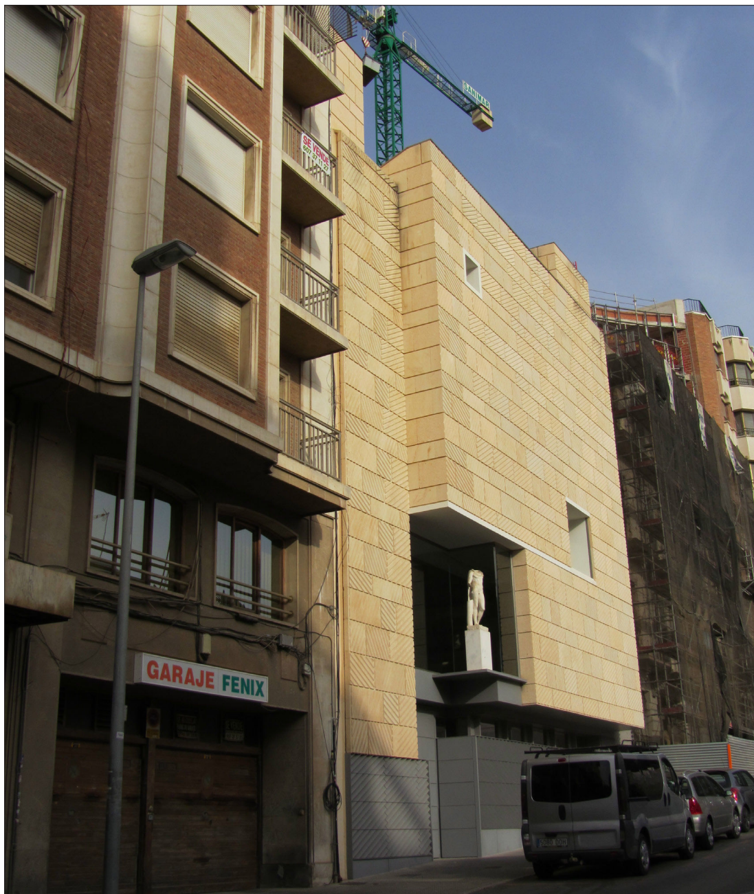
Figure 4.16 Vue de l'extérieur du nouveau bâtiment de Rafael Moneo à partir de la rue General Órdóñez. (Alexandra G. Paquin, 2011.)
