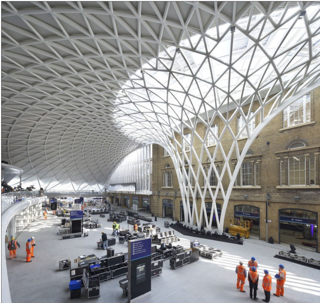
Figure 5.4 Transformation de la gare King's Cross de Londres, Angleterre. John McAslan & Partners, 2012. (©Hufton and Crow. Tiré de < http://www.archdaily.com/219082/kings-cross-station-john-mcaslan-partners/mainimagekings-cross-2-hufton-and-crow/ >, consulté le 4 juillet 2012.)
