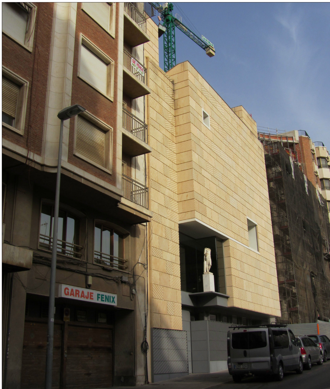
Figure 4.16 Vue de l'extérieur du nouveau bâtiment de Rafael Moneo à partir de la rue General Órdoñez. (Alexandra G. Paquin, 2011.)
