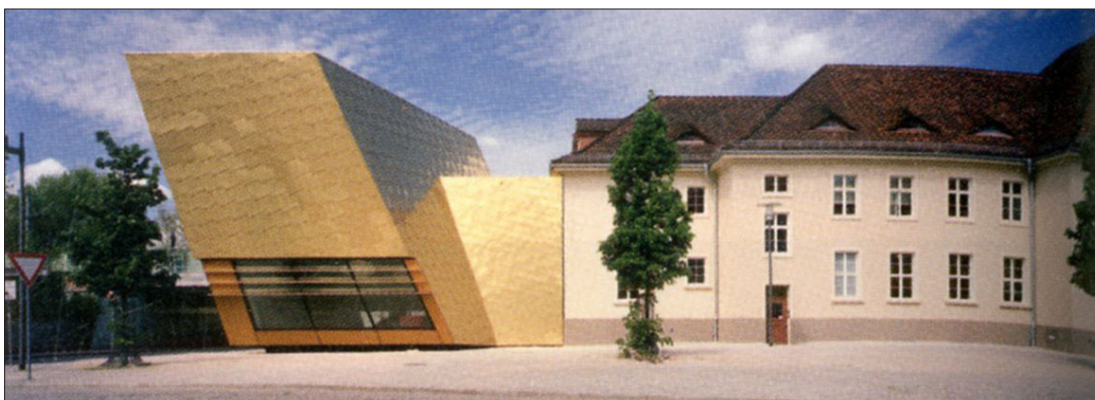
Figure 3.2 Ancienne gare reconverte en bibliothèque à Luckenwalde, Allemagne. Extension de FF Architekten, 2009. (Tiré de Arca , 2009.)
