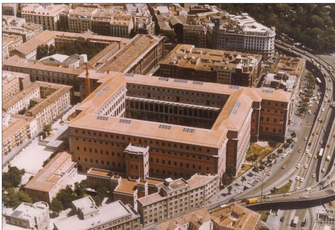
Figure 3.22 Vue aérienne du CARS, 1986 ? Nous pouvons voir en avant-plan les différents pavillons qui abritaient les services auxiliaires du ministère de l'Éducation et l'Institut national de baccalauréat à distance jusqu'à leur démolition, en 2001. Jean Nouvel a repris la forme triangulaire de l'espace vacant pour y construire son annexe. (Photo : Joaquín Cortés. AC-MNCARS, n° temporaire 6546.)
