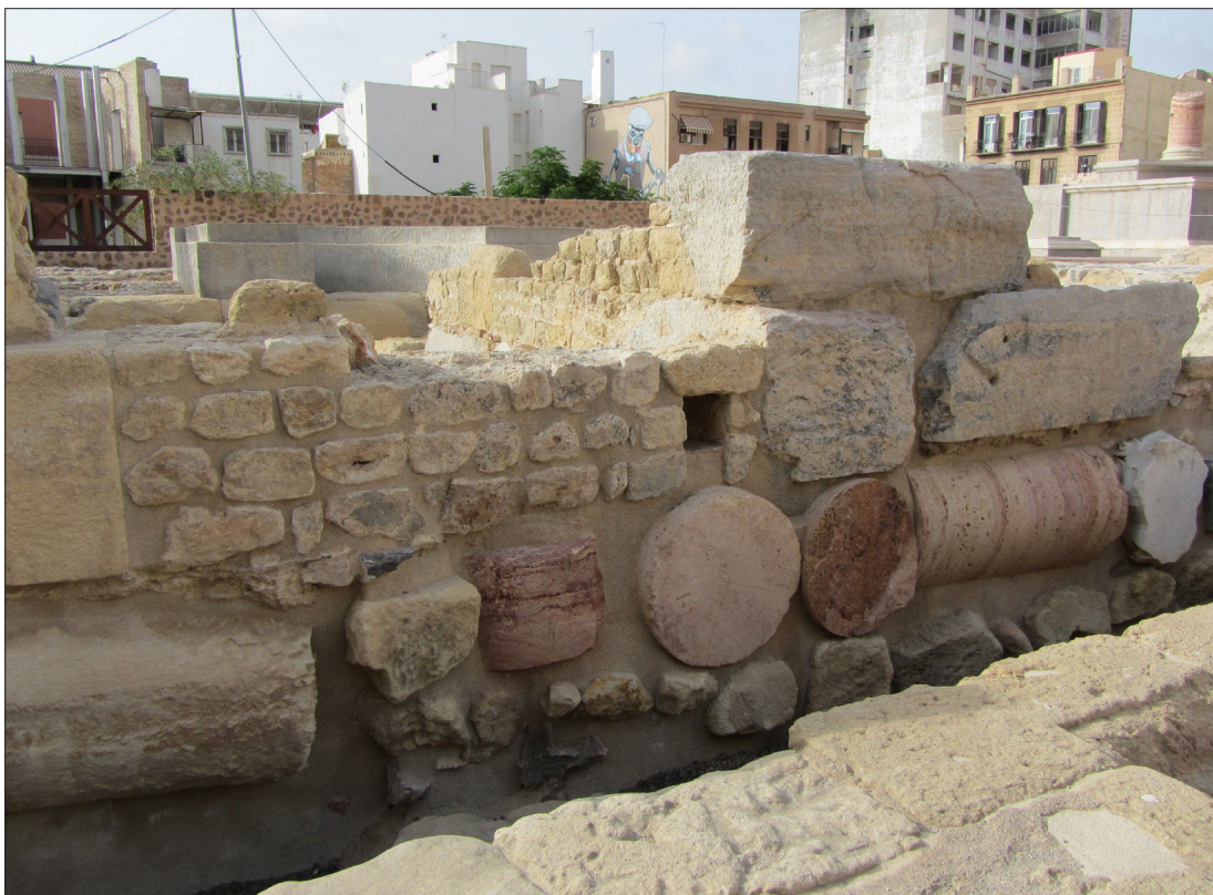
Figure 4.9 Intégration de différentes parties du théâtre dans la structure du marché du V e siècle, comme des bouts de colonnes. (Alexandra G. Paquin, 2011.)
