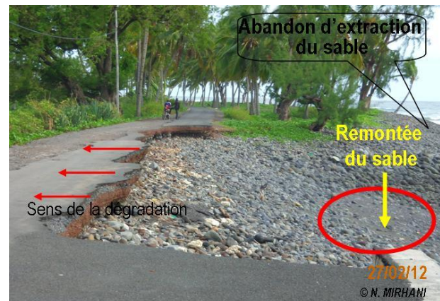
Photo 64- Remontée du sable et dégradation continue de la route après abandon d'extraction du sable
