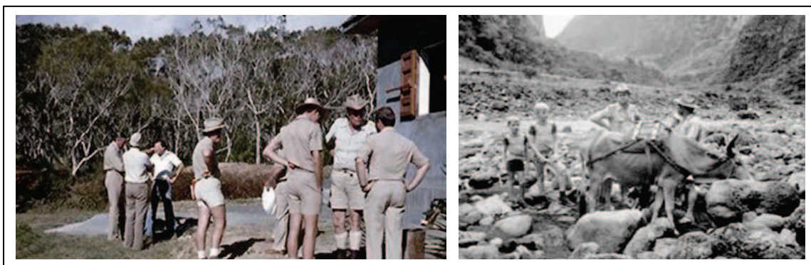
Photo.9 Agents ONF et chantier route forestière Bélouve, années 1970 (source : JIR).
