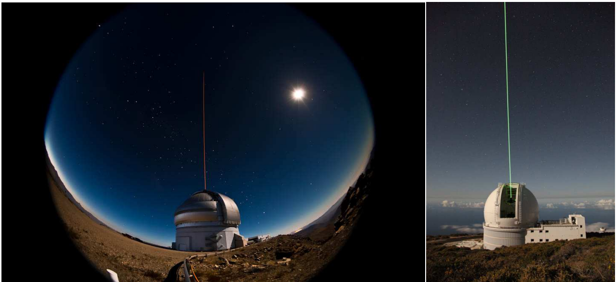
FIGURE 3.2: À gauche : tir laser à Gemini Sud avec l'instrument GEMS utilisant une constellation de 5 étoiles sodium ( Crédit : Gemini Observatory/AURA). À droite : Tir laser en Juillet 2012 au William Herschel Telescope avec l'instrument CANARY utilisant une étoile laser Rayleigh.
