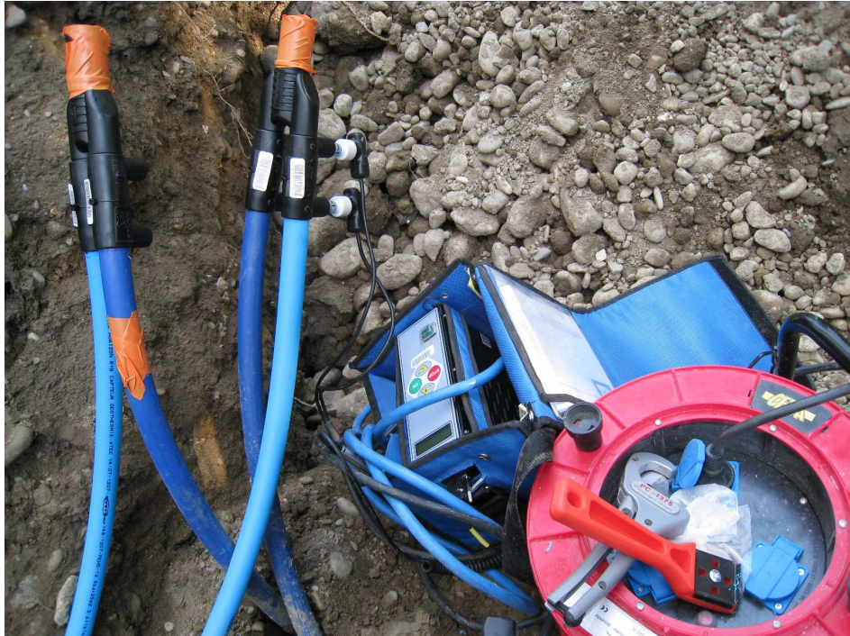
FIGURE 2.5 – Thermosoudure avec Y
