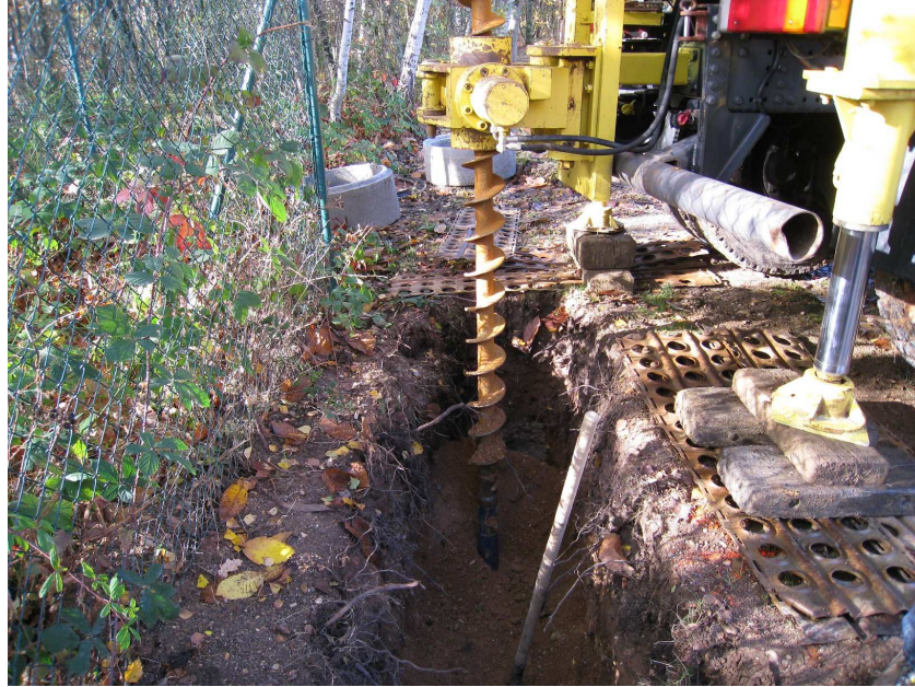
FIGURE 1.5 – Forage à 10 m avec une tarière (BRGM, Orléans)
