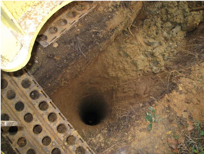
FIGURE 1.6 – Forage à la tarière (BRGM, Orléans)
