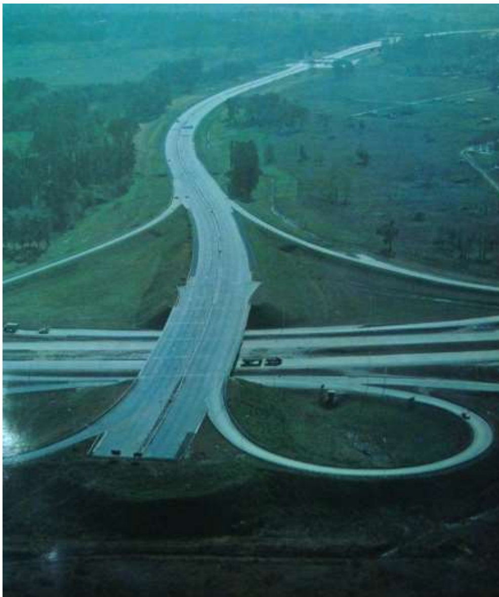
Photo 2.2. La construction du Camino al Buen Ayre (CEAMSE-b, 1979)
