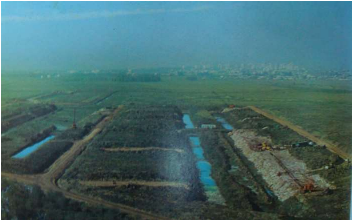
Photo 2.3. Vue aérienne de la construction du site de Villa Domínico (CEAMSE-b, 1979)
