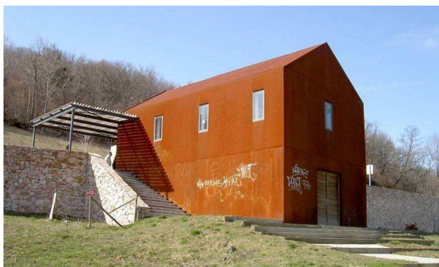
Construction sur une aire de l'autoroute A75, au sud de Saint Chely d'Apcher, Lozère
