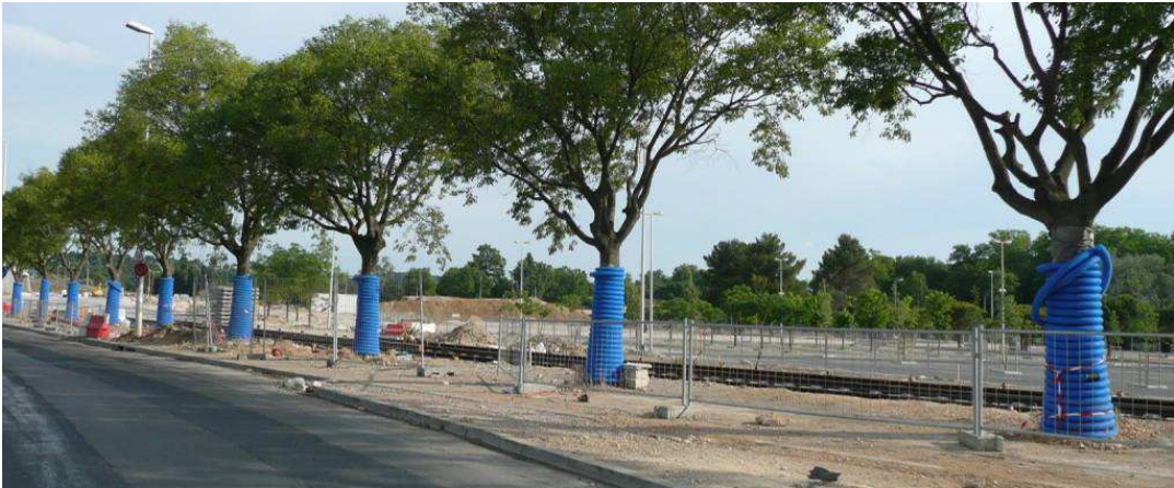
Chantier de voirie, Montpellier, Hérault - 2010
