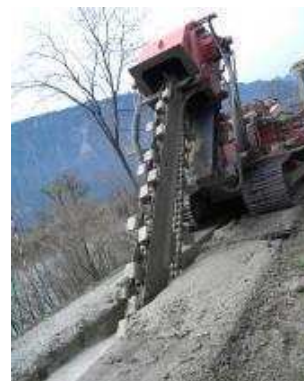
FIGURE 1.4 – Mise en œuvre de tranchées traitées en place par trancheuse ( sources : [Jeanty et al., 2013] et site internet Stucky ).
