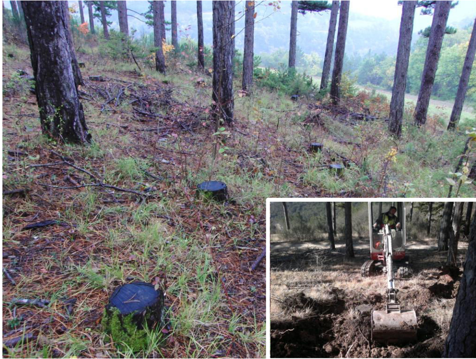
Figure 28 – Extraction de souches à la pelle mécanique, Forêt de Saint Genis, France (cliché Bigot, 2012)
