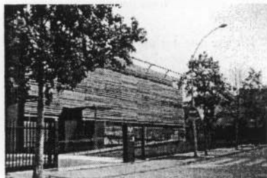
figure 6-43 : bâtiment à façade épaisse à Marseille
