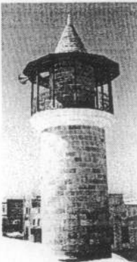
Saïda, Liban Minaret avec balcon ombragé, source: James Steele, p. 40.
