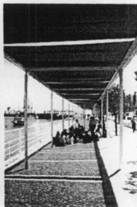
Figure 6-32 : Protections solaires par résilles, Expo 98 à Lisbonne
