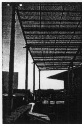
Figure 6-30 : Protection solaire métallique, Expo 98 à Lisbonne.
