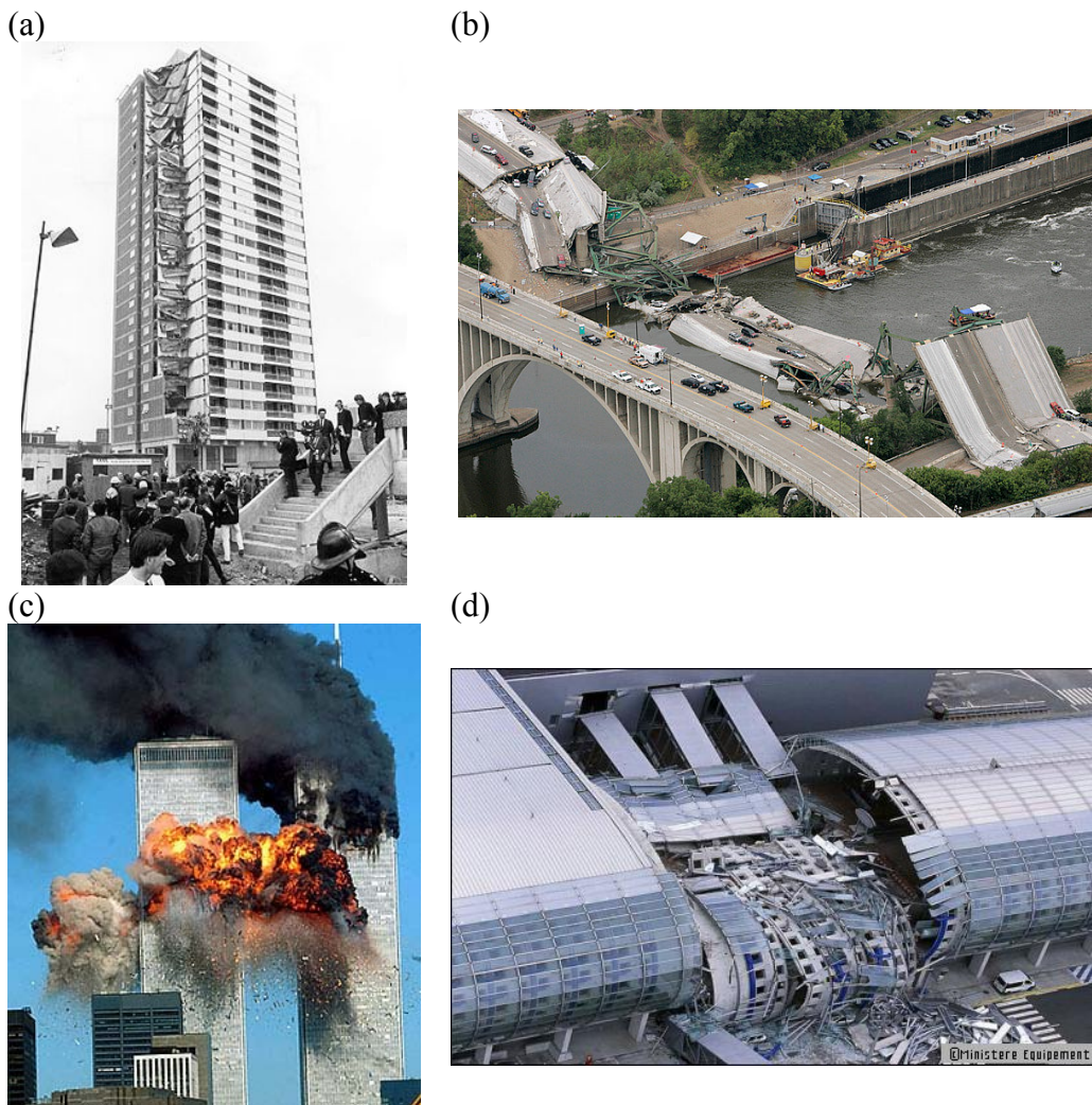
Figure 1.1. Effondrement (a) de la Tour du Ronan point, (b) du Pont de Minneapolis, (c) des Tours jumelles du World Trade Centre et (d) du Terminal 2E aéroport CDG.
