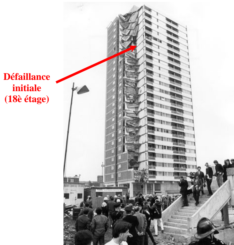
Figure A.1. Effondrement de la tour de Ronan point suite à une explosion de gaz (Wikipedia).
