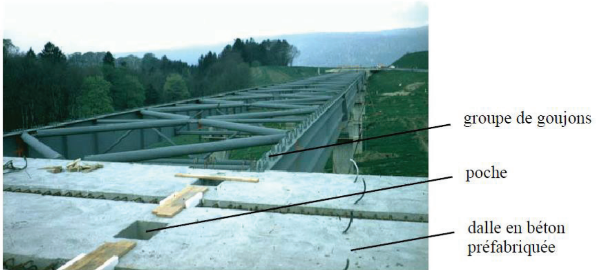
Figure 1.1 : Connexion de la dalle préfabriquée à l'aide de groupes de goujons
