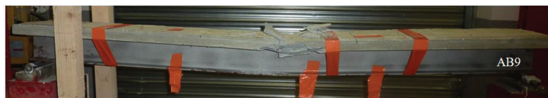
Rupture de AB9 et AB16 par écrasement du béton
