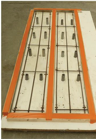
(a) Coffrages des dalles avec les armatures et les tiges PVC
