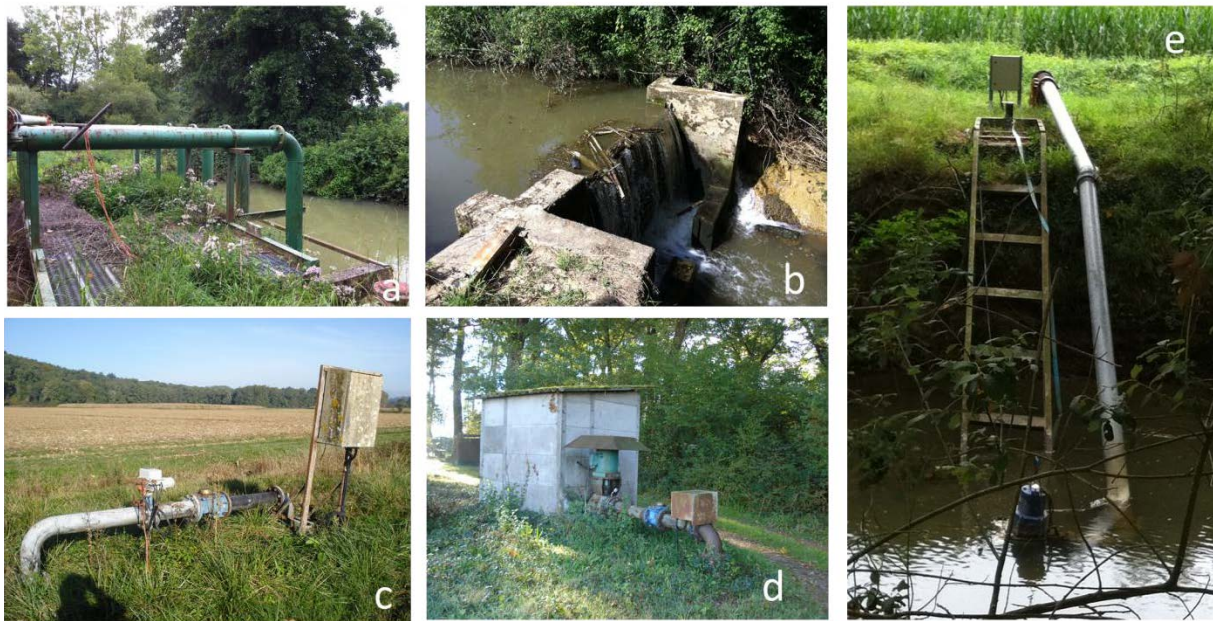
Figure 1-18 : Photos des différents ouvrages destinés à l'irrigation dans la région d'Audignon. a. pompes de prélèvement dans le Laudon, b. systèmes de batardeaux pour augmenter le niveau dans le Laudon, c. et d. forages agricoles d'Eyres-Moncube (Crétacé), e. pompe immergée dans le Gabas
