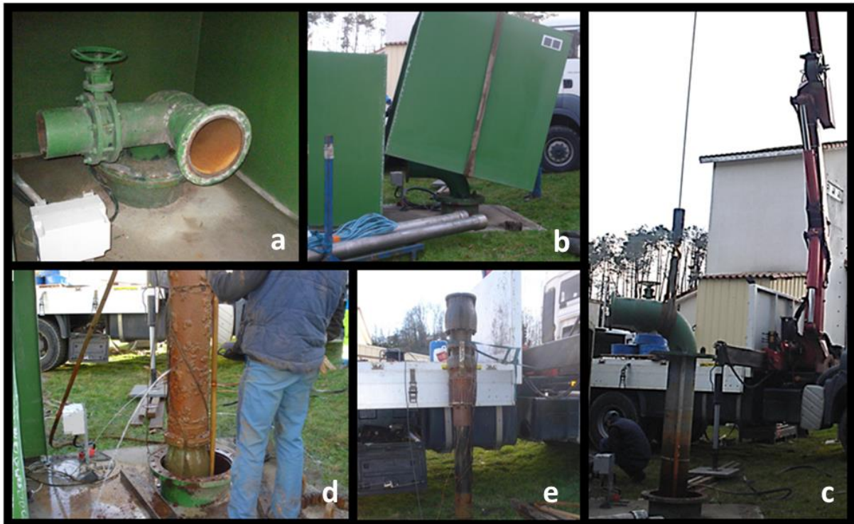
Figure 4-15 : Les différentes étapes de la remontée de la pompe par les équipes d'Hydro-Assistance en février 2011. a : la tête de forage F1, b : la cabine de protection est soulevée, c : la tête de forage et la colonne sont remontées, d : la colonne de pompage en mauvais état, e : la pompe du forage F1
